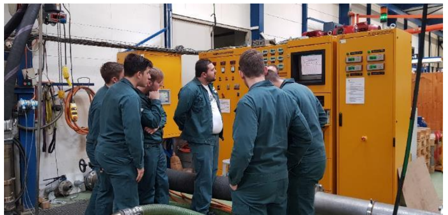
CP-Betrieb: Erklärung von Pumpenprüfung auf Dichtheit
